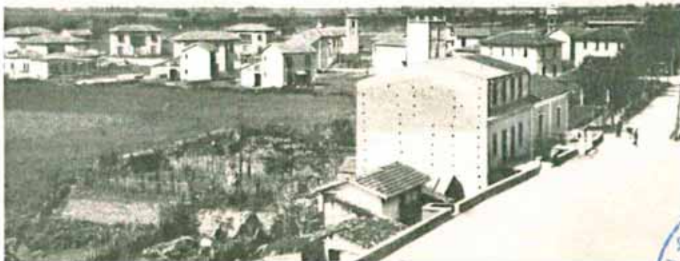
Il nuovo villaggio di Sant'Eufemia subito dopo la bonifica
